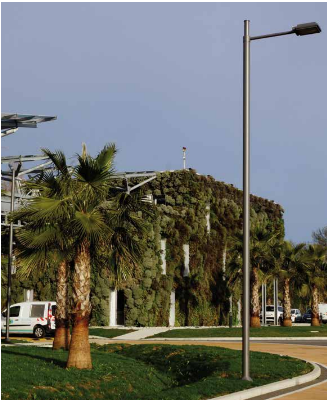
Cannes, Station d'épuration Aquaviva Maîtrise d'ouvrage: SIAUBC Maîtrise d'ouvrage délégué: Lyonnaise des Eaux Architecte: Jean de Giacinto Photographie: PL Technilum®
